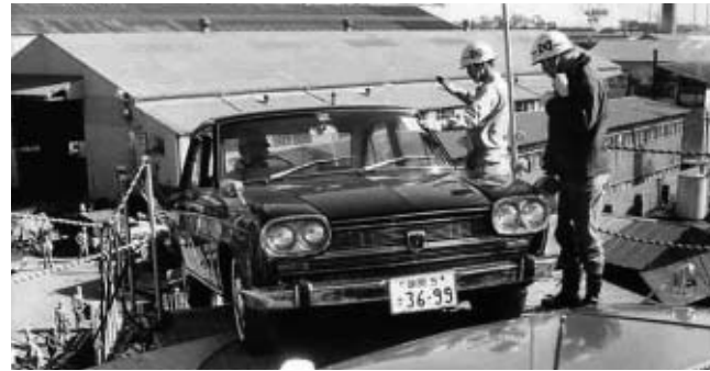
明電丸荷役/Loading
