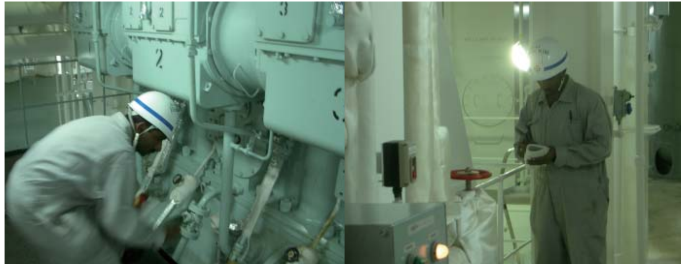
エンジンルーム内点検中 / Inspecting the engine room
